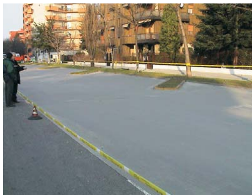
Posa della malta fotocatalitica a basso spessore.
